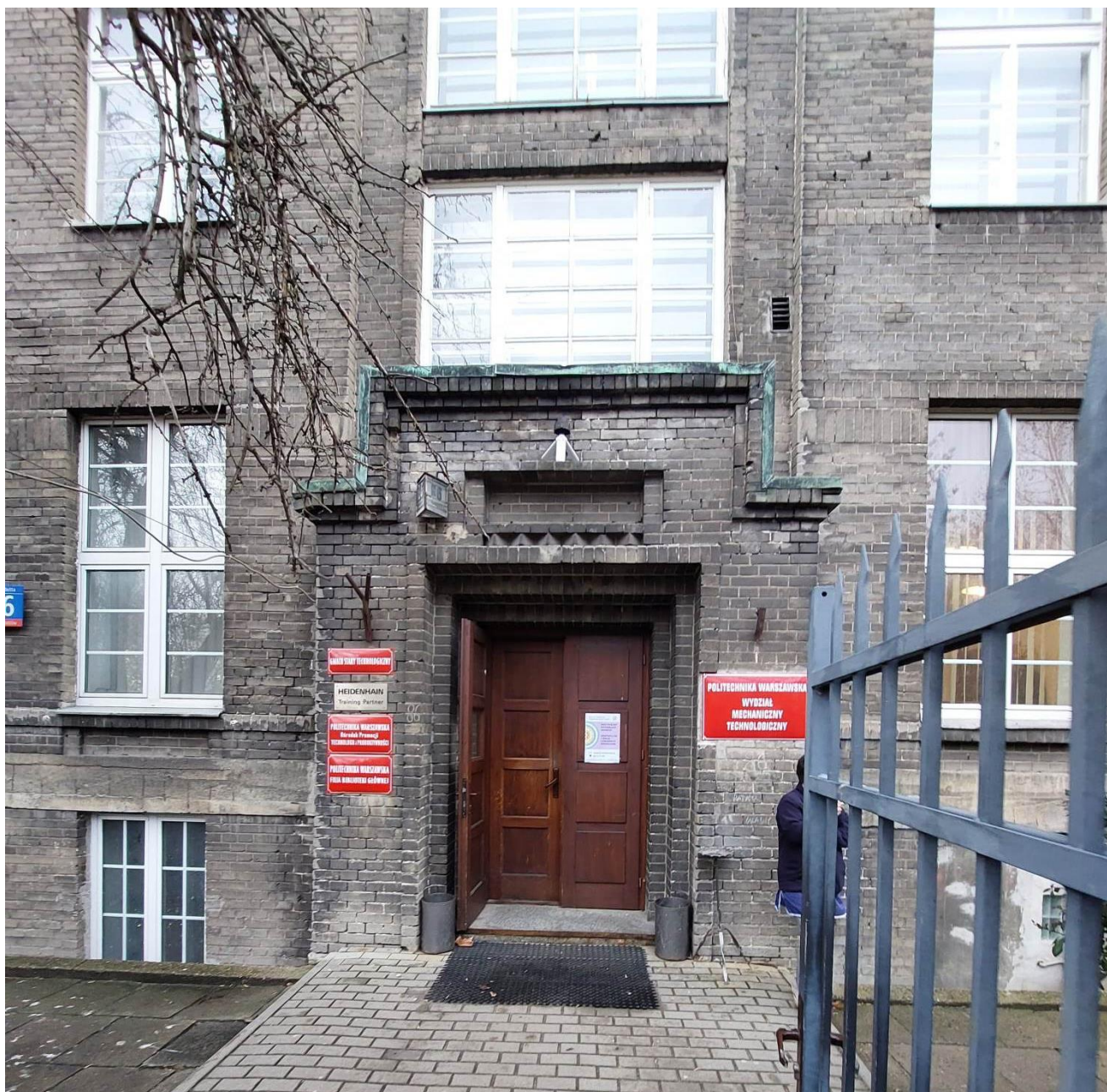
Zdjęcie 4 Wejście do budynku – drzwi dwuskrzydłowe, w przedsionku znajdują się schody bez możliwości pokonania za pomocą podnośnika.
